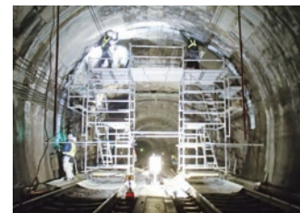
トンネルの補修工事の様子
