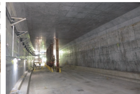
産業道路駅付近での躯体構築状況
