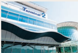
羽田空港 第2旅客ターミナルビル
