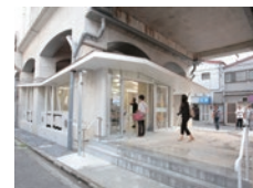
高架下スタジオSite-D
